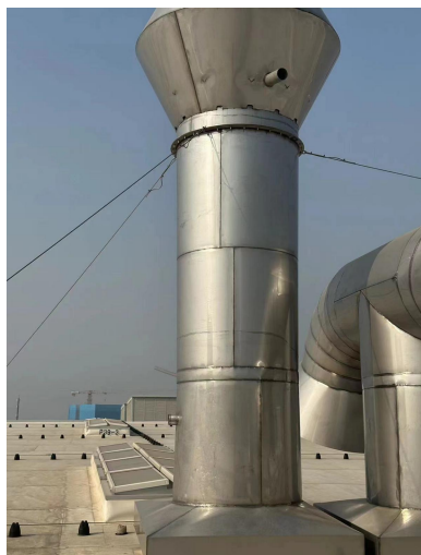
燃烧器天然气燃烧废气排气筒
