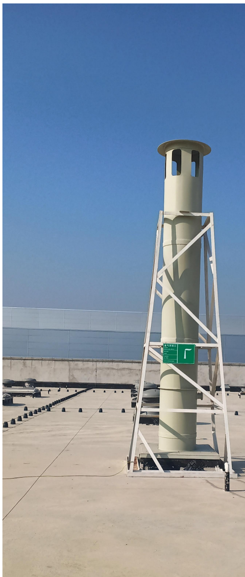
污水处理站废气排放口标识
